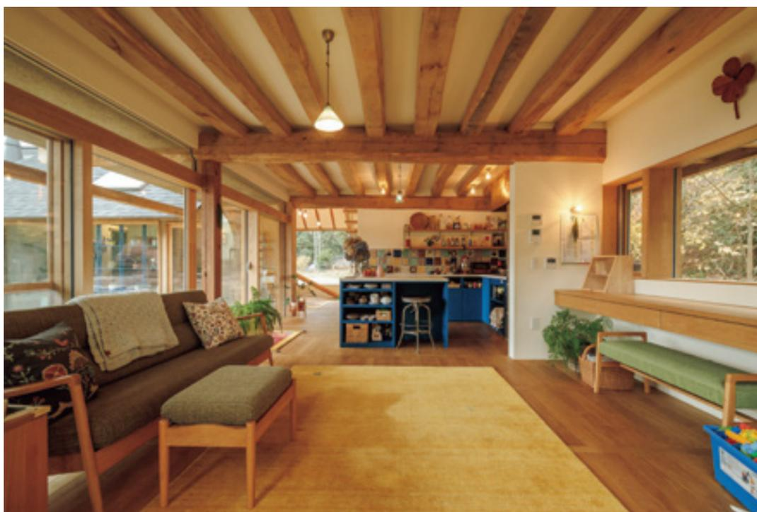
背後の森と一つとなるように立つT邸。ベルギーの民家の建て方に学び、自然の木の形をそのまま生かして組み上げている。「チャーチ」と名付けた吹き抜けには天井から床まで一面に窓を設けた。鉄平石を敷いた場所には薪ストーブを置く予定。
