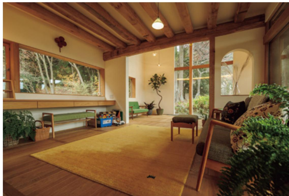
天井の梁の自然の木のラフさに心が和むリビング。朝日が昇る美ヶ原を見晴らす東側に大開口を設けた。西側にはわが家の森が寄り添っている。床はクリ材。同じ長さの木材を整然と並べ、繋ぎ目に床材を差し込む「大陸張り」にしている。
