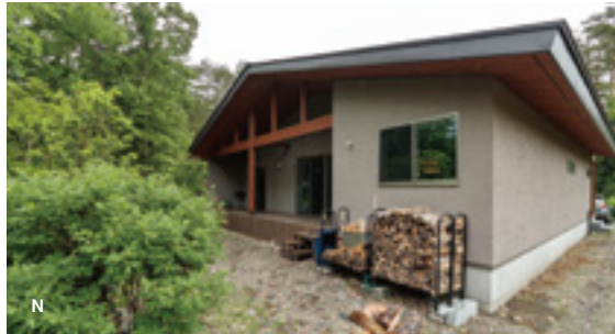
N_雪深い地域ゆえ、テラスは80cmほどの高さ にしている。O_玄関はスギ羽目板の壁で目隠し。 奥にはタイヤや除雪機などの収納も。
