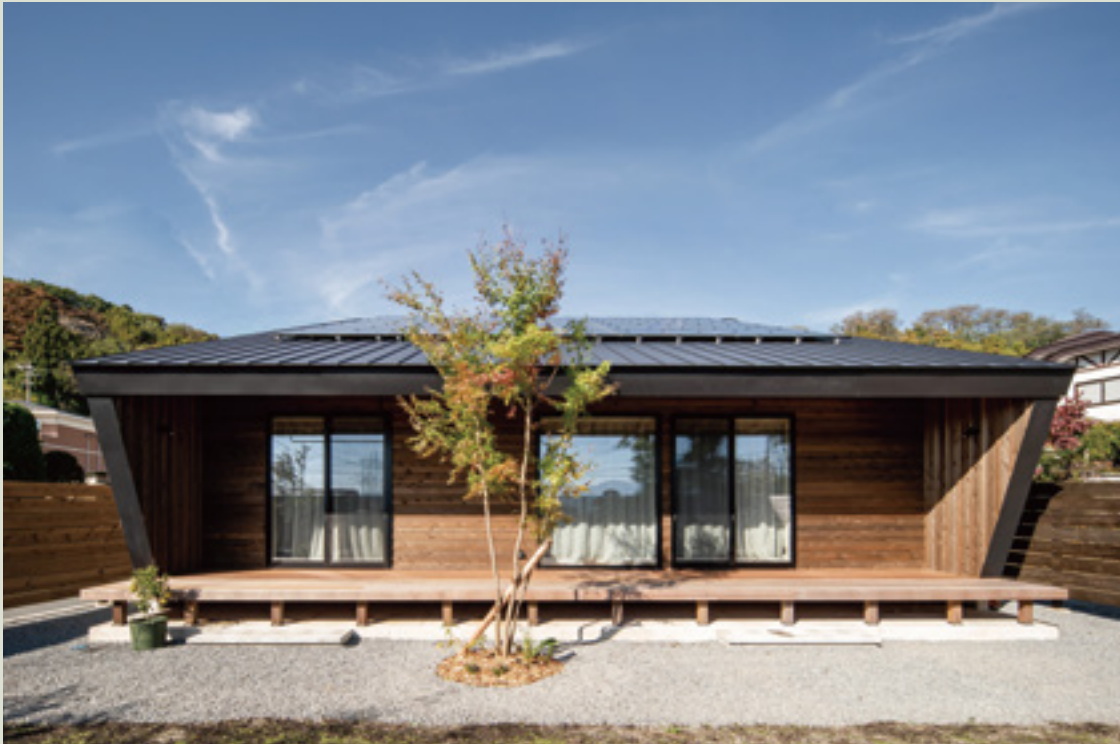
地元の天然木を使った健康的で快適な家を得意とするアーキエアーズの設計・施工で、外壁にはスギ材が多用されている。 発電した電力は自家消費に充てることが可能。10年ほどで黒字になることが見込める契約プランを利用している。
