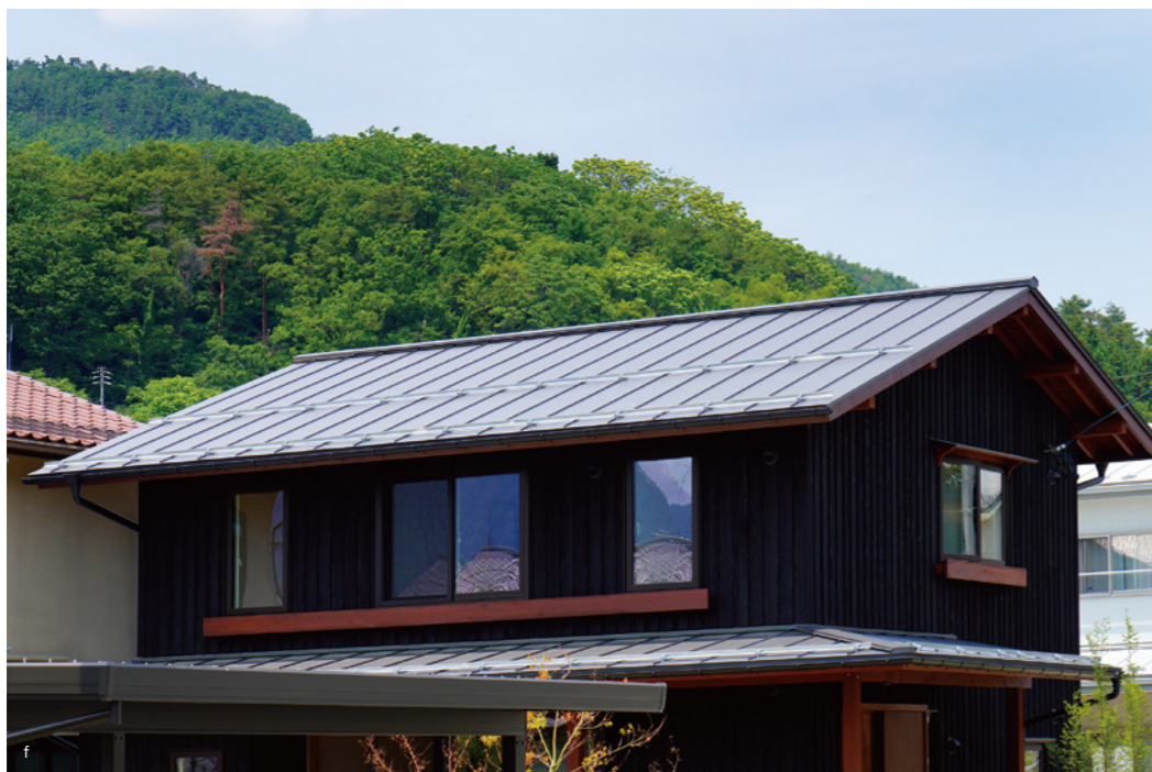
f_建物高を抑えているから山の緑も見通せる。家を建てることで、もとからあった風景を損なうのではなく、むしろ引き立てる。そんな家づくりがまちの景観を良くしていく。 g_リビングから玄関まで下屋を巡らせたことで、ウッドデッキは動線としても機能する。
