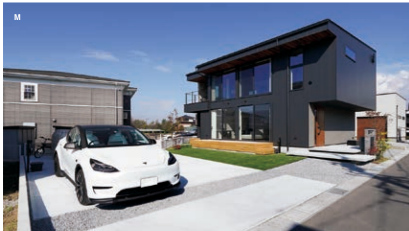
M 駐車スペースも含め、余分な装飾のないシンプルでモダンな外観。駐車場には充電設備を設けた。玄関から車の前まで続く砂利下に、雨水浸透トレッチが配されている。
