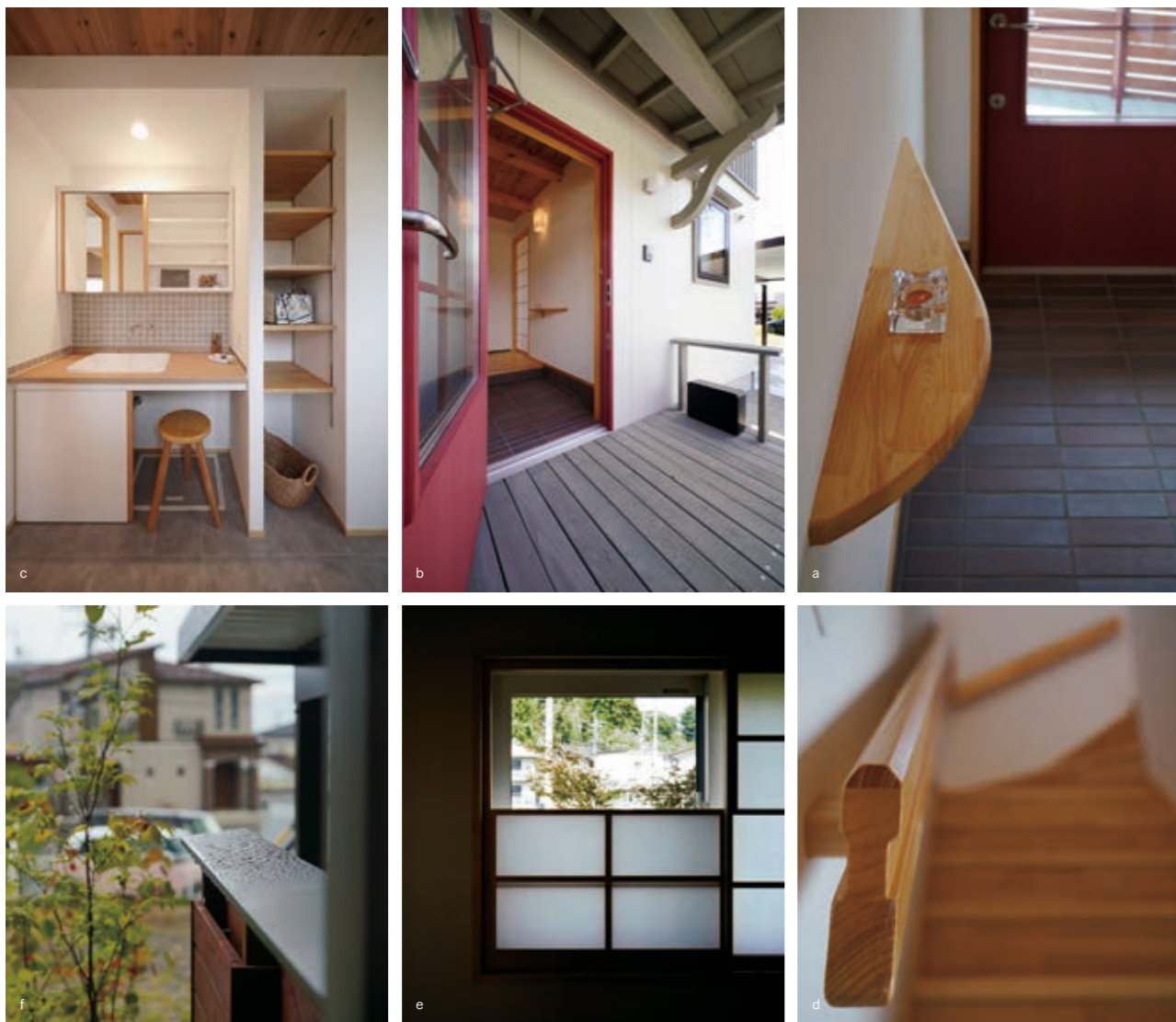
a_ 玄関に入って右手にしつらえた手すり。飾り棚を思わせるデザインで、手を添えてすつと段差をのぼれるよう奥に向けて広がっている。 b_ 家族やお客様を迎える玄関アプローチは、屋根が深く雨天でも濡れにくい。軒下にはマツの無垢材から彫刻する縁起のいい招き猫の手も。 c_ 掃除がしやすいシンプルな洗面台。 d_ 職人技が光る階段の手すり。しっかりと握れる形と素材にこだわっている。階段は12段と最少にし、のぼりやすさや安全性に配慮した。 e_ 柔らかな光を取り込む障子。開閉が調整できるのも嬉しい。 f_ ガルバリウム鋼板でつくられた板塀の笠木。雨が降っても水がたまらないよう斜めになっている。
